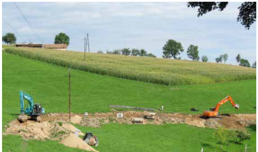
Abb. 1: Kanalbau im ländlichen Raum © GSA
