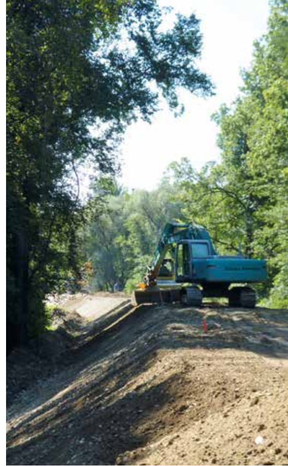
Abb. 2: Sanierung und Erhöhung des Murdamms © A14
