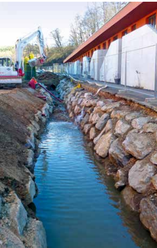
Abb. 4: Hochwasserschutzmaßnahmen Stufenbach - Bachöffnung © Eisner ZT GmbH / Rakusch
