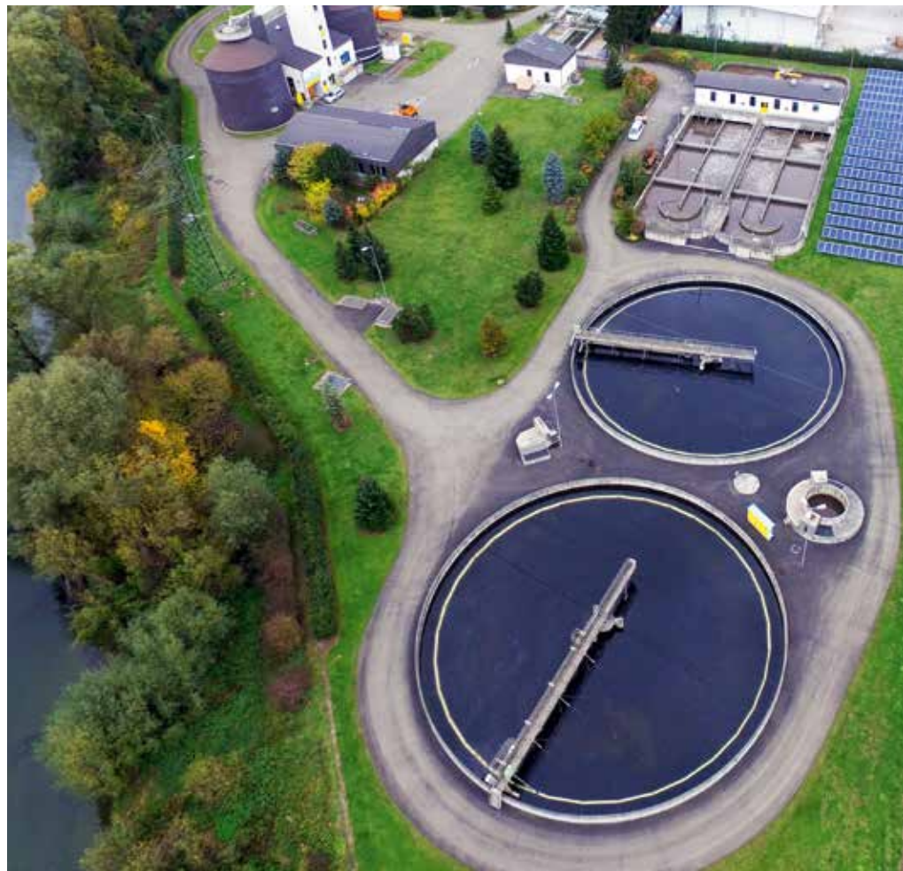
Abb. 2: Kläranlage Kapfenberg – Mürzverband © GSA
